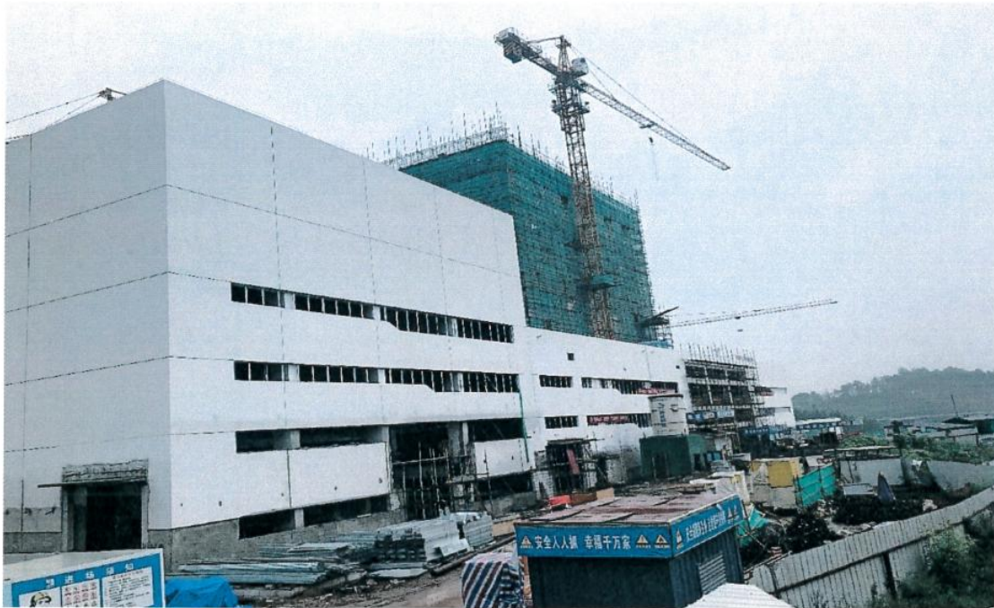
图 1：建德市垃圾焚烧发电项目现场（2020 年 9 月 16 日）
